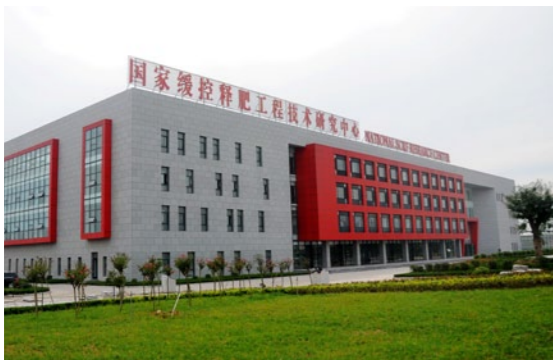
国家缓控释肥工程技术研究中心科研大楼
